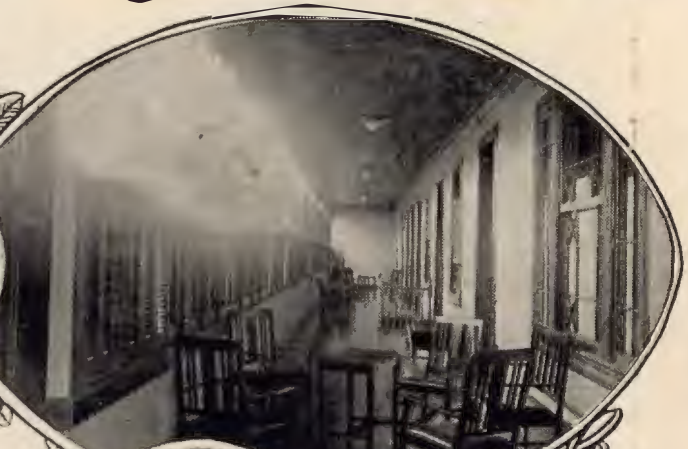
Hall de los Salones Laterales
